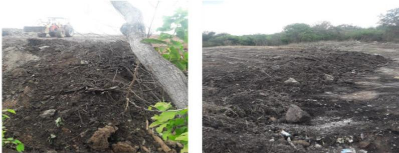
Se ha aprovechado de una tierra que llega al Vertedero procedente de trabajos de limpieza en la Ruta Interamericana Norte para continuar las labores de liquidación final y para mantener la configuración de los taludes.
