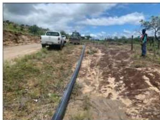
*Tubería de 150mm PEAD en línea de conducción San Bernardo - Tanque de Lajas*
