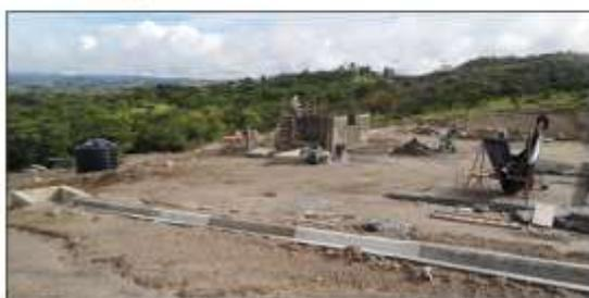
*Sitio del tanque Laja Azul, construcción de cuneta hexagonal, caseta de cloración y colocación del reservorio.*
